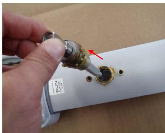
Die Seilspule am Seil aus dem Mast ziehen, das alte Seil lösen und wie unten abgebildet, das neue gleich wieder einziehen.
