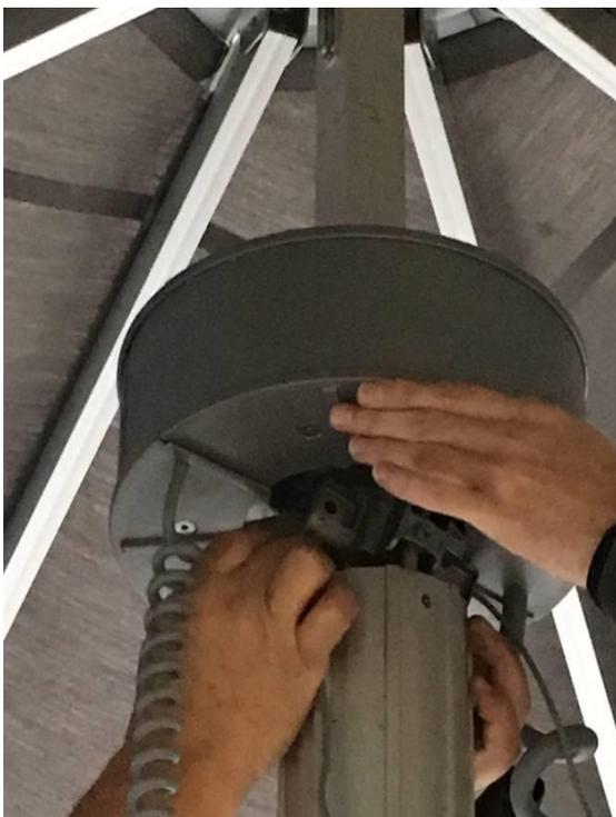
5. Steuerung abheben (falls vorhanden), Schrauben der Verdrehlager entfernen und Verdrehlager aus dem Masten heben. Rollen tauschen.
