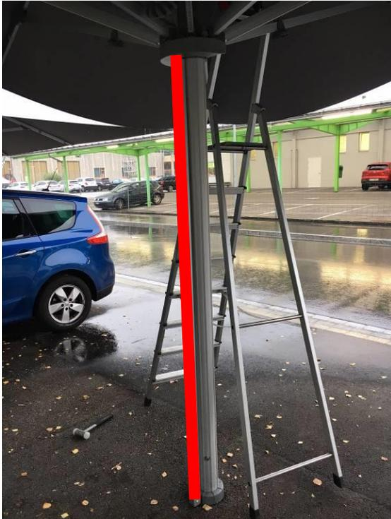
4. Schieber mit einem Stab unterstützen, damit die Seile entlastet werden.
