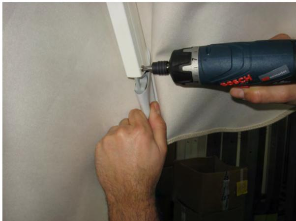
Schrauben an Streben Verlängerung lösen.
